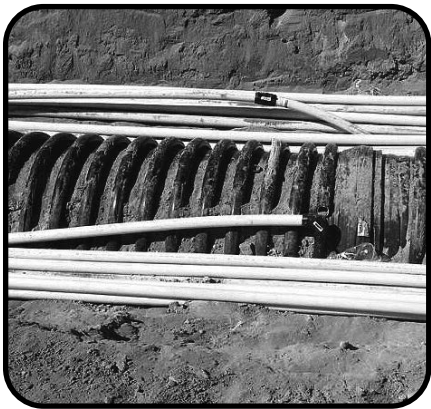
Einfacher Anschluss der Anbindeleitungen mit Heizwendelschweißmuffe
